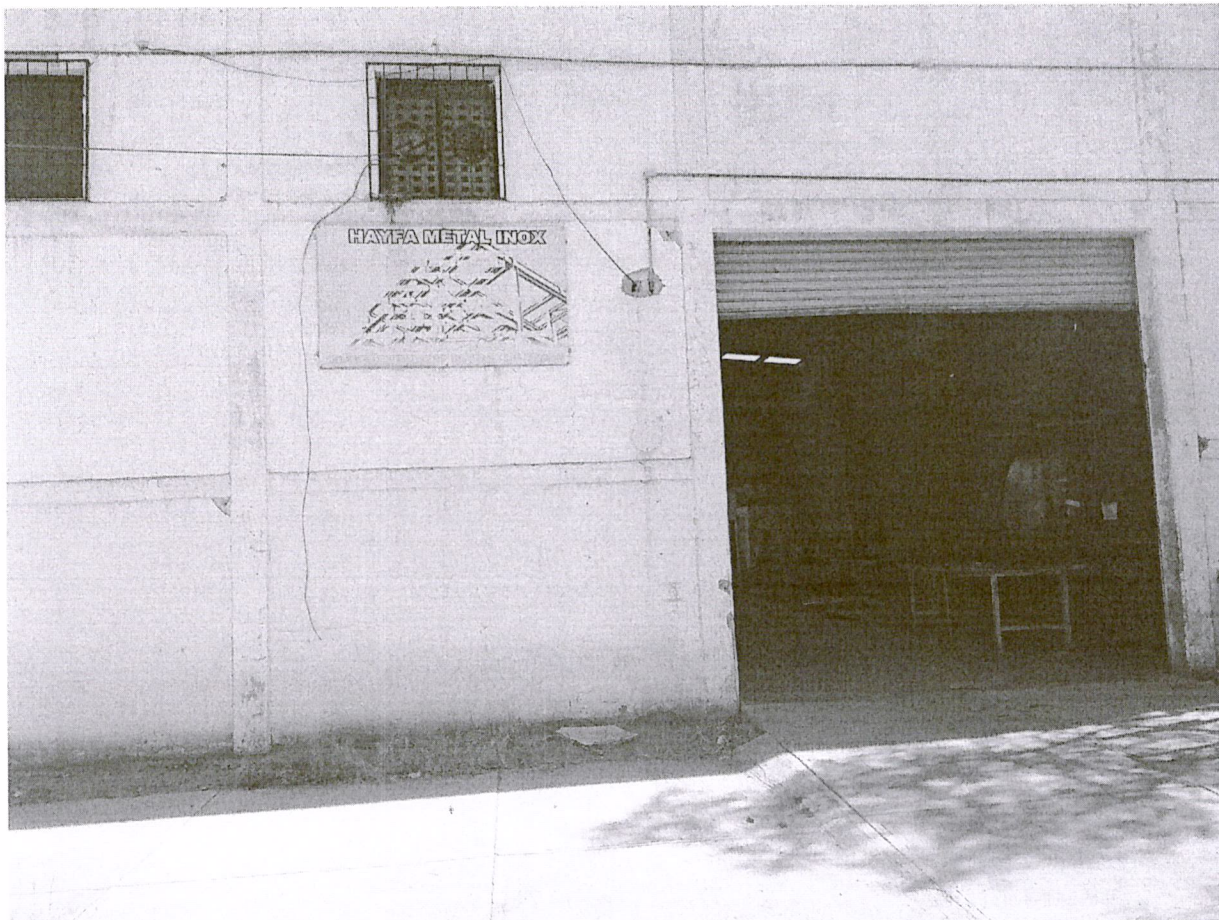
Fotografía toma de la parte posterior de la nave Industrial de este domicilio fiscal, con salida ubicada en calle Roberto Dávila, en la Ciudad Industrial Torreón, en la Ciudad de Torreón, Coahuila de Zaragoza, C.P. 27019.
