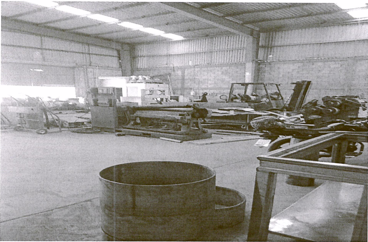
Fotografía toma del Interior del lado izquierdo de la nave Industrial de este domicilio fiscal, ubicado en calle Alberto N SWAIN No. 60 Interior 1, en la Ciudad Industrial Torreón, en la Ciudad de Torreón, Coahuila de Zaragoza, C.P. 27019.
