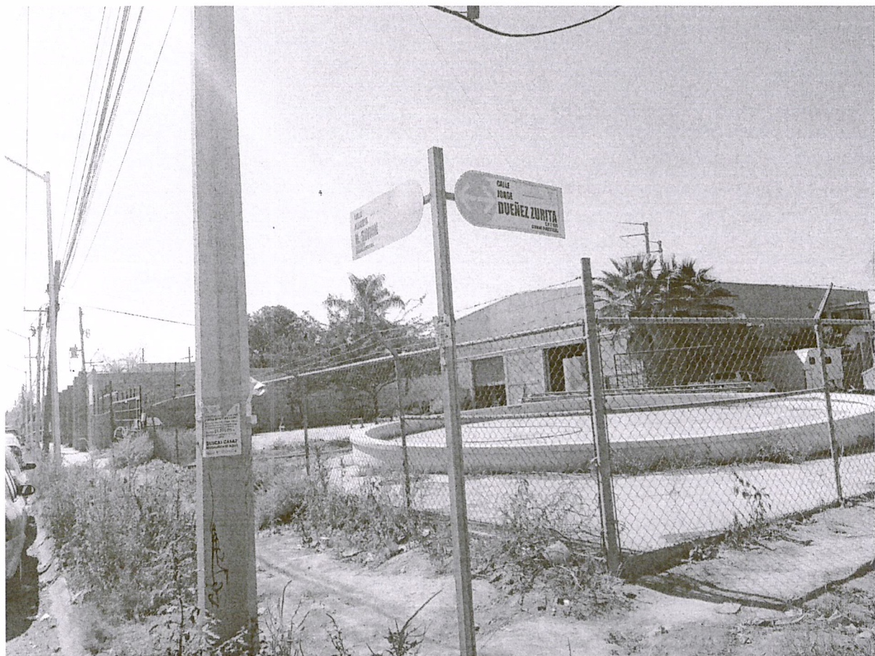
Fotografía toma de la esquina del exterior de la nave Industrial de este domicilio fiscal, que colinda con la calle Alberto N Swain y la calle J Dueñez Zurita en la Ciudad Industrial Torreón, en la Ciudad de Torreón, Coahuila de Zaragoza, C.P. 27019.
